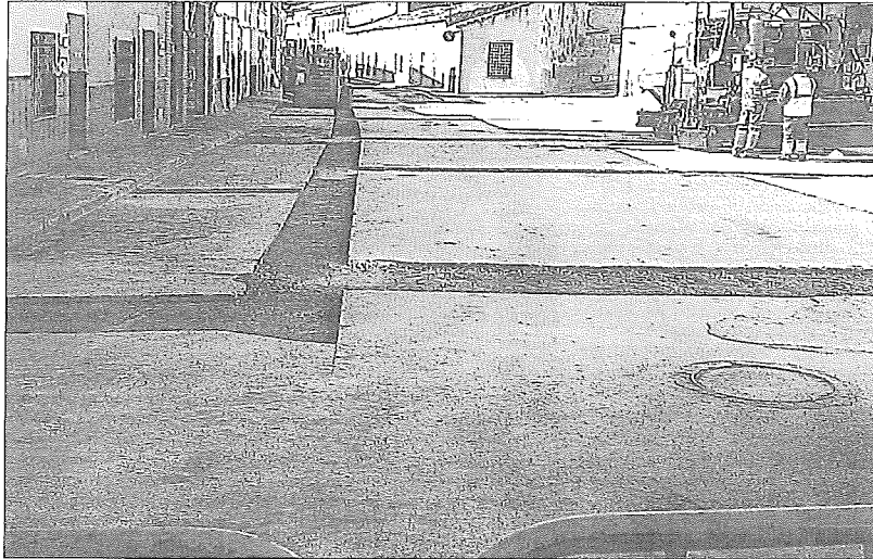
La calle Columnas, en la mañana de ayer, antes de iniciar la fase de asfaltado con las que se concluyen las obras. / G. GONZÁLEZ
