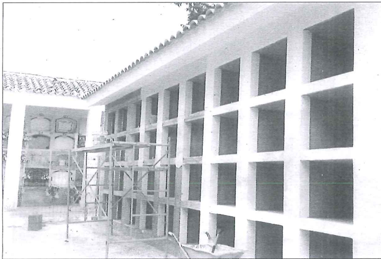
Imagen de las obras prácticamente finalizadas. / G. G.
