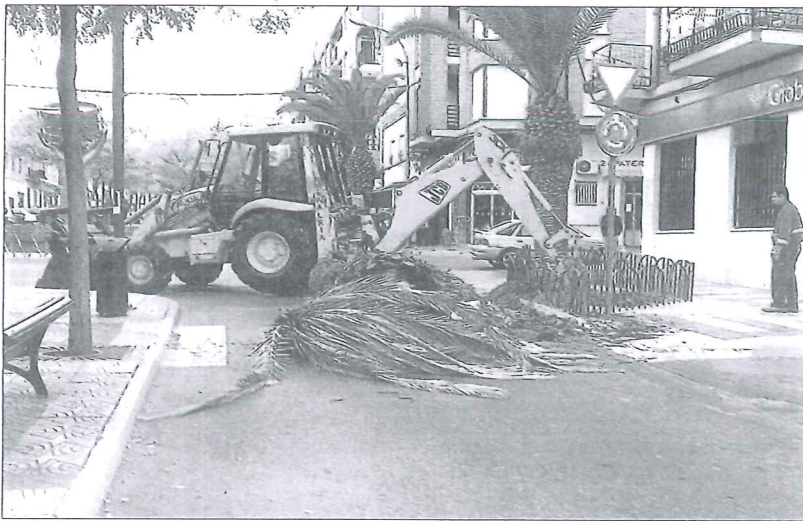
Talado y retirada de la palmera de la Avenida de la Constitución. / G.G.
