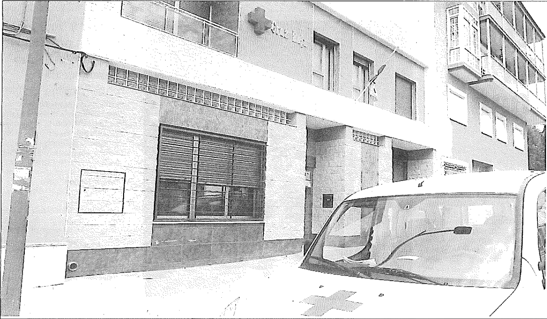
Fachada del nuevo edificio de Cruz Roja, que se inauguró el año pasado y que ha necesitado de la partida más importante de gastos. / G. G.
