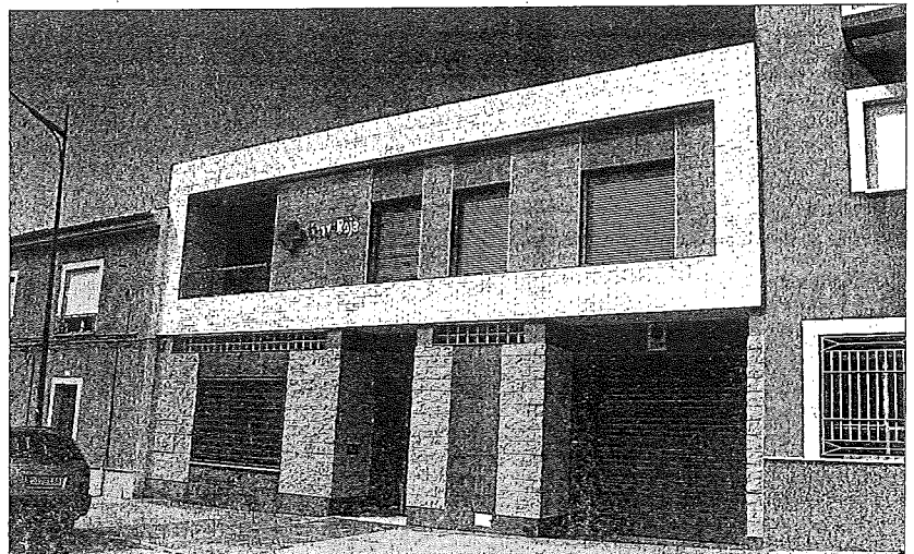
Los servicios de Cruz Roja ya se ofrecen desde las nuevas instalaciones, que se inaugurarán el próximo día 20 de octubre. / CRE
