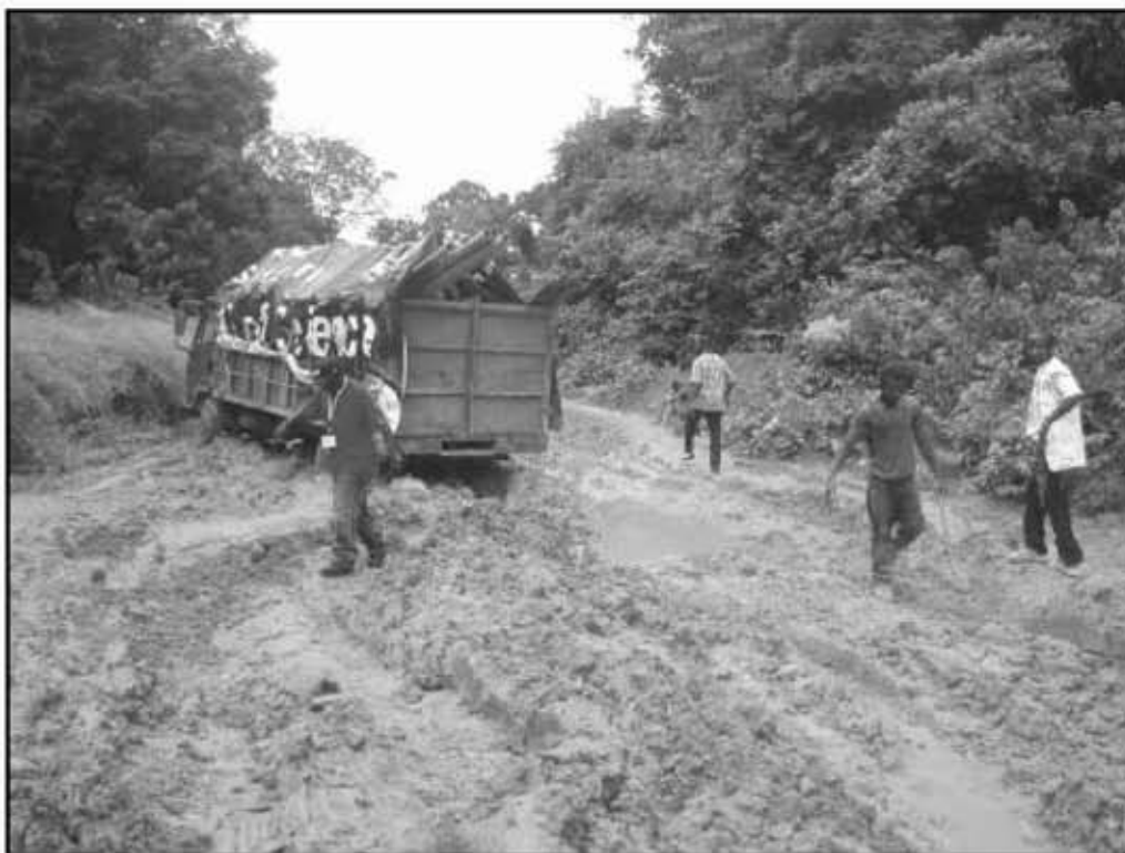
Carretera de acceso a Sinoe, en época de lluvias.
