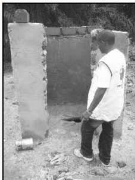
Letrinas en construcción
