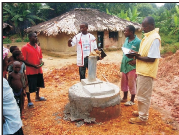
Construcción pozo de agua potable en Liberia
